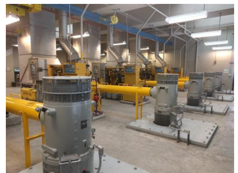
Effluent Pumps
